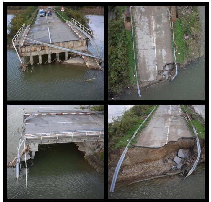
Vizuelna inspekcija havariisanog mosta
